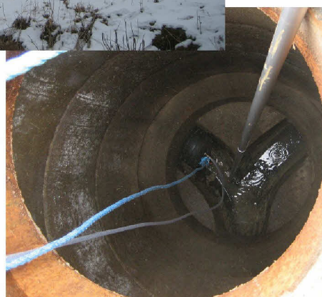
Provisorisk proppning under ombyggnaden
